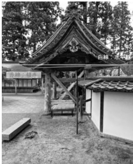
本坊表門 解体前（傾斜）
