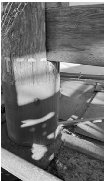
本坊表門 根継ぎされた柱
