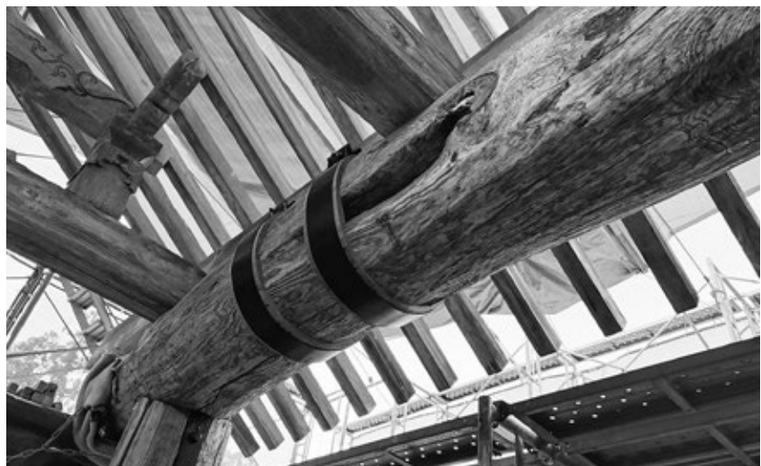
本坊表門 補強された牛曳き梁
